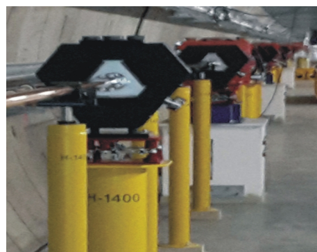
图 10 新型离子泵作为定位基准安装
